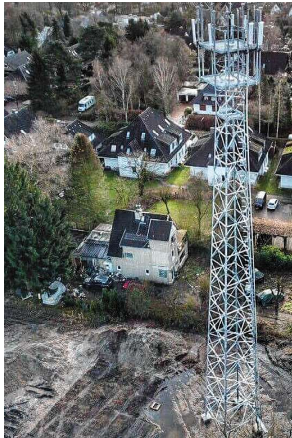
Die Grenze zwischen Schleswig-Holstein und Hamburg verläuft entlang des Knicks (vorn im Bild) am Feldrand unterhalb des Funkmasts. HEINRICH FLÜGGE
